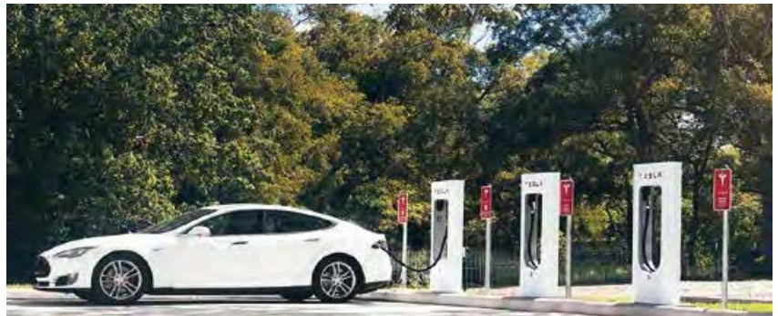
Stromtankstelle des Elektrofahrzeugherstellers Tesla
