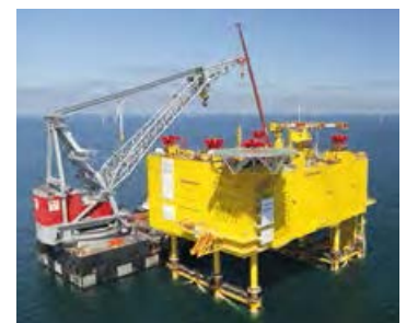
Umspannplattform für den Windpark SylWin1. Hier wird der in den Windkraftanlagen generierte Wechselstrom in Gleichstrom umgewandelt und verlustarm per Seekabel an Land transportiert
